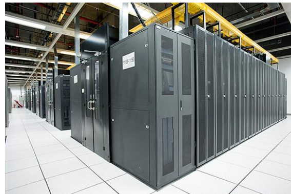
データセンター内部
