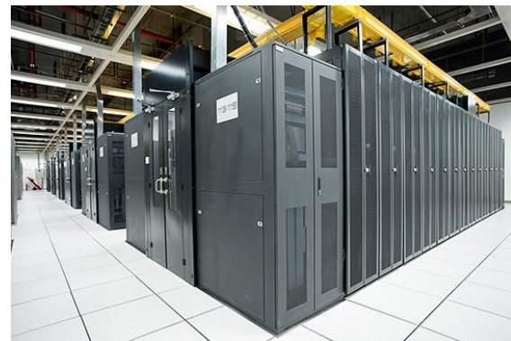
データセンター内部
