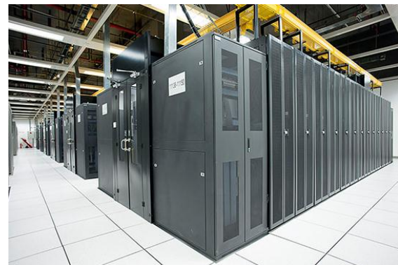
データセンター内部
