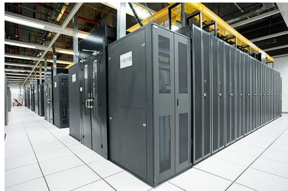
データセンター内部
