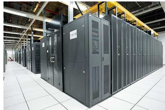
データセンター内部
