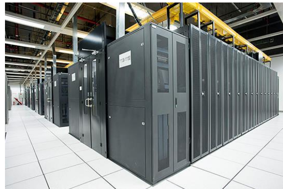
データセンター内部
