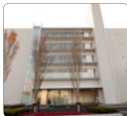
多摩第4ネットワークセンター
