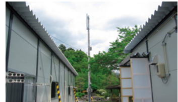
仮設住宅近隣に新設したau携帯電話基地局
