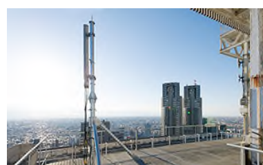
KDDI 新宿ビル屋上に設置された大ゾーン基地局アンテナのひとつ
