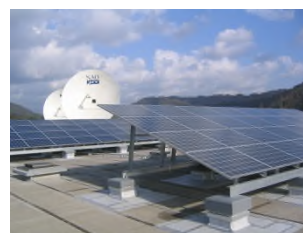
自然エネルギーを採用する大型通信局
