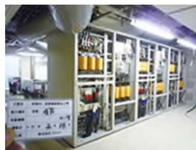
旧 800MHz 帯対応基地局の電源設備
