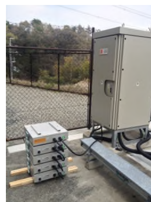
可搬型蓄電池
