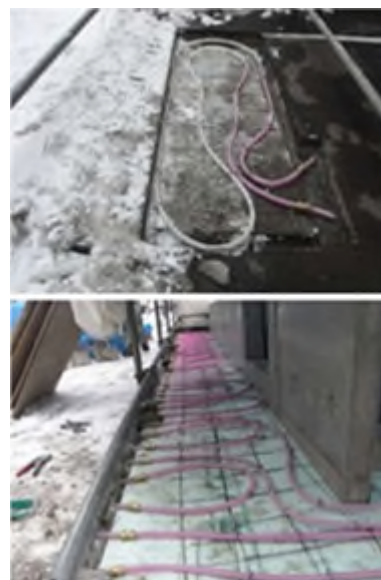
ロードヒーティング設備
