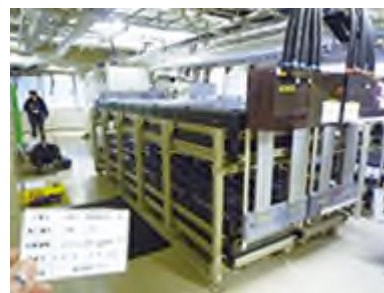
旧 800MHz 帯対応基地局のバッテリー (蓄電池)
