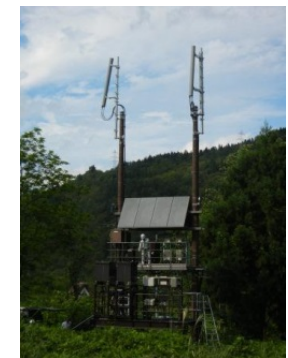
積雪を避けるために、合掌造り風の屋根と高床式に建設されたau基地局
