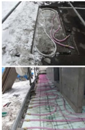
ロードヒーティング設備
