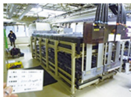
旧800MHz帯対応基地局のバッテリー（蓄電池）
