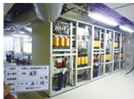
旧800MHz帯対応基地局の電源設備
