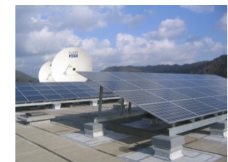
自然エネルギーを採用する大型通信局
