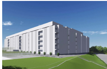
「TELEHOUSE TOKYO Tama 3」 外観イメージ
