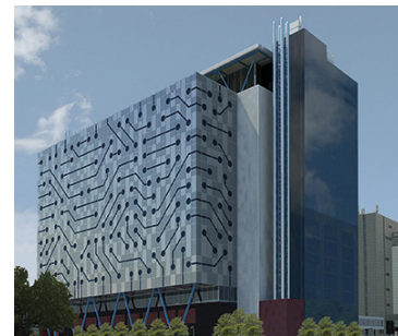
TELEHOUSE LONDON Docklands North Two 外観イメージ
