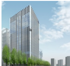
「TELEHOUSE OSAKA 2」 外観イメージ
