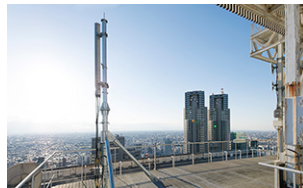
KDDI新宿ビル屋上に設置された大ゾーン基地局アンテナのひとつ
