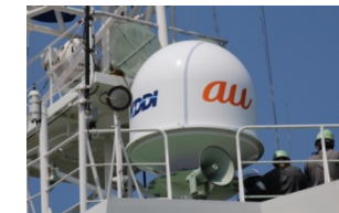
巡視船「さつま」のブリッジ上に設置された実証試験用の携帯電話基地局
