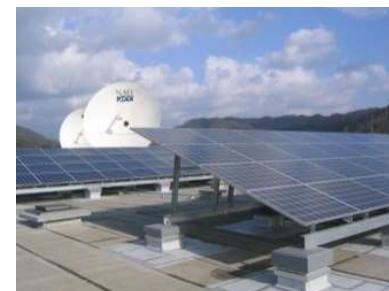
自然エネルギーを採用する大型通信局
