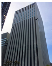
「TELEHOUSE OSAKA 2」 外観
