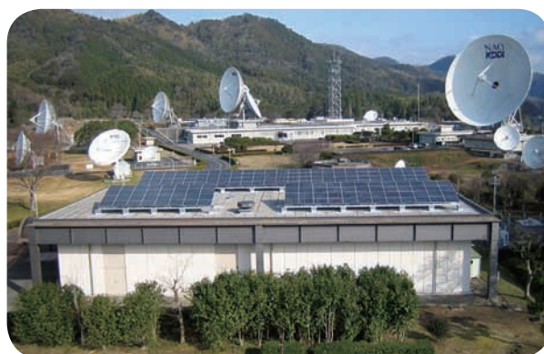
山口衛星通信所「KDDIパラボラ館」のソーラー発電システム
