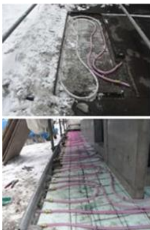
ロードヒーティング設備
