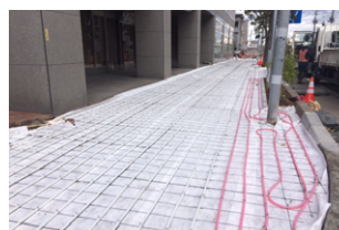
ロードヒーティング設備
