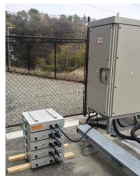
可搬型蓄電池
