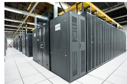
データセンター内部
