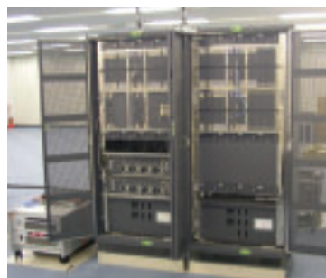
新世代移動通信システム実証実験装置(基地局)
