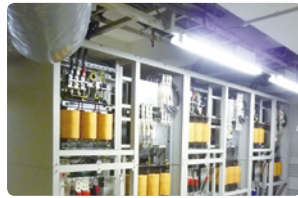
旧800MHz帯対応基地局の電源設備
