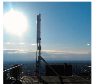
KDDI新宿ビル屋上に設備された大ゾーン基地局アンテナのひとつ
