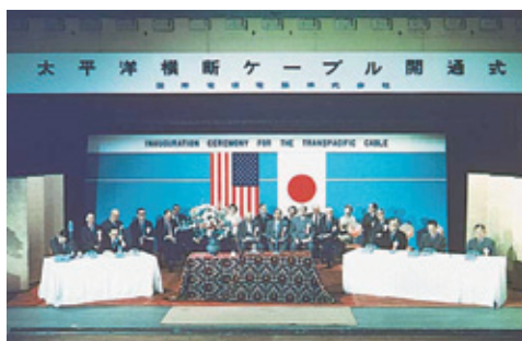
米ロングライズ号から神奈川県二宮へ陸揚げされる、日米間初の海底同軸ケーブル第1太平洋横断ケーブル(TPC-1)。その下の写真は、TPC-1の開通式
