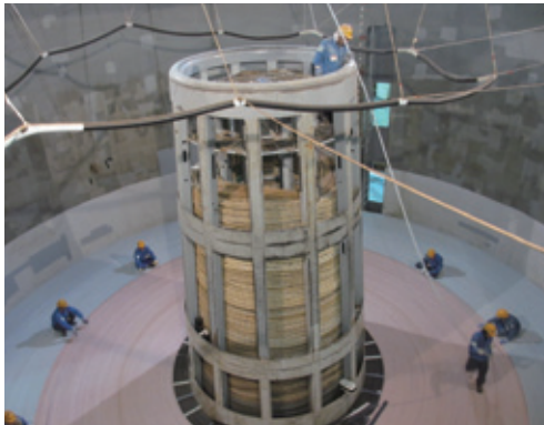
ケーブル敷設船「KDDI PACIFIC LINK」内のケーブルタンクに積み込まれる「SJC」ケーブル
