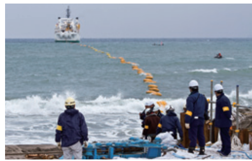
2012年11月19日、光海底ケーブル「SJC」の陸揚げ工事で、千葉県南房総市千倉沖合約1kmに停泊したケーブル敷設船「KDDI PACIFIC LINK」から繰り出される光海底ケーブル
