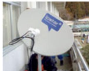
衛星通信を介したauフェムトセル用アンテナ(宮城県石巻市)
