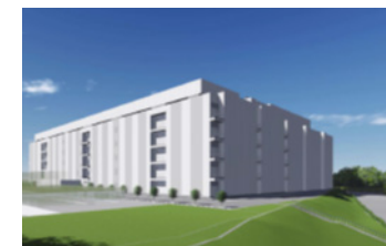
「TELEHOUSE TOKYO Tama 3」外観イメージ
