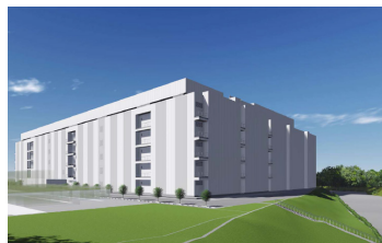
「TELEHOUSE TOKYO Tama 3」 外観イメージ
