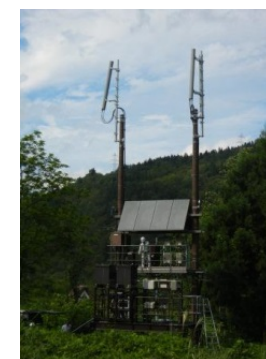
積雪を避けるために、合掌造り風の屋根と高床式に建設されたau基地局
