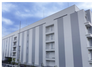
「TELEHOUSE TOKYO Tama 3」外観
