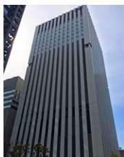
「TELEHOUSE OSAKA 2」 外観
