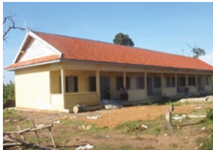
カンボジアに建設された小学校
